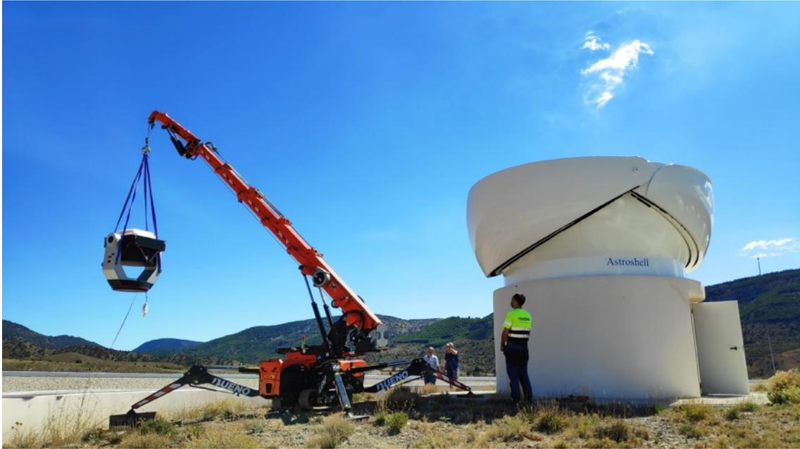
Labores de montaje del telescopio GT80 en el interior de su cúpula en Galáctica. /CEFCA
